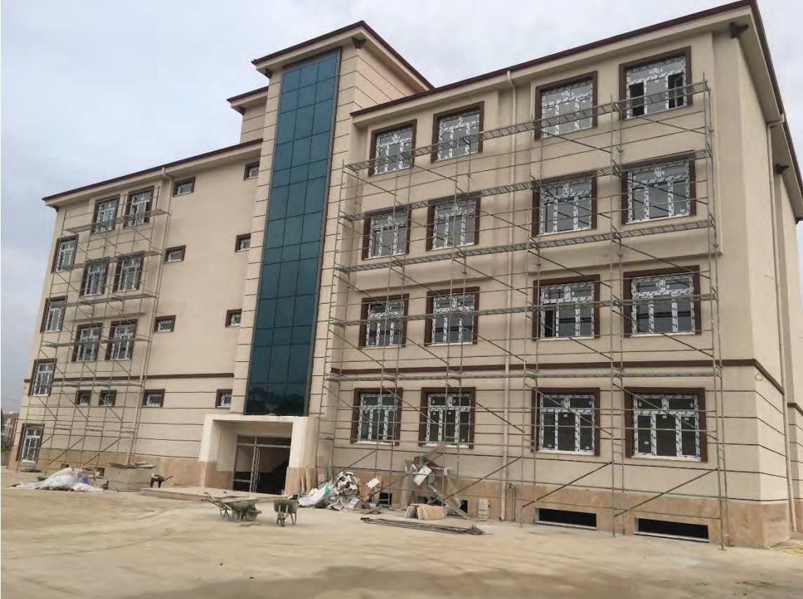
Sultaniye 16 Derslikli İlkokul Binası Yapım İşı
