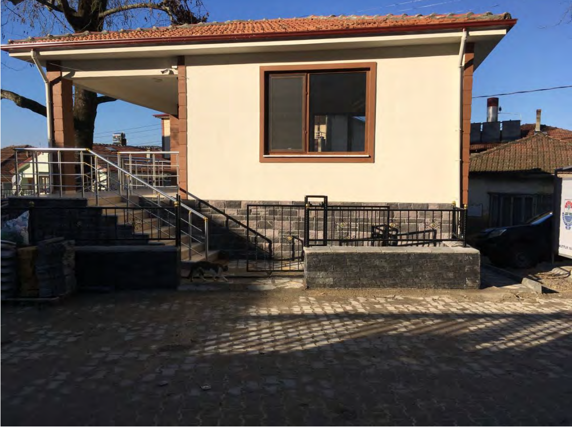
Safran Köyü Muhtarlık Binası Yapım İşı
